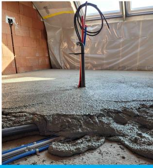
Le LDS ExcellLight est facile à installer, retient l'eau et peut être fini plan.
