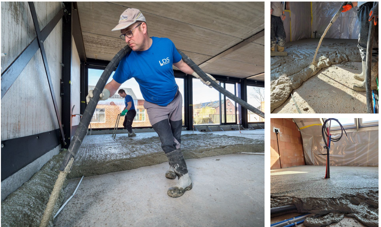
Le LDS ExcellLight est facile à installer, retient l'eau et peut être fini plan.
